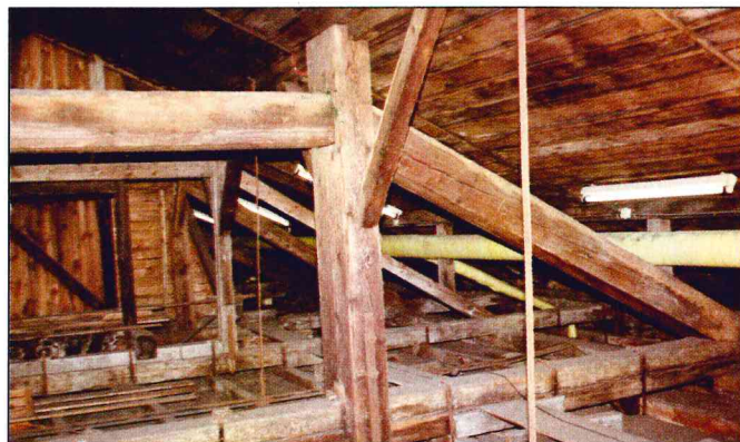
8 Dachkonstruktion des Siedehauses (Detail)
